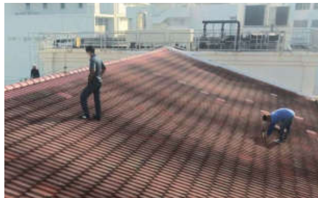
งานบูรณะหลังคาอาคารสถานียา และอาคารอำนวยการ
