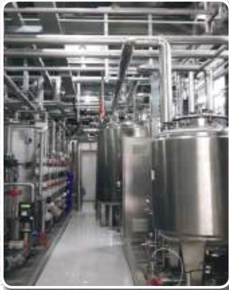
ระบบผลิตน้ำบริสุทธิ์ น้ำกลั่น และไอน้ำบริสุทธิ์ ยี่ห้อ Stilmas จากประเทศจีน สำหรับใช้ผลิตเซรัมและยาปราศจากเชื้อ
