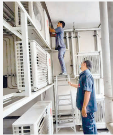
งานซ่อมเครื่องปรับอากาศ
