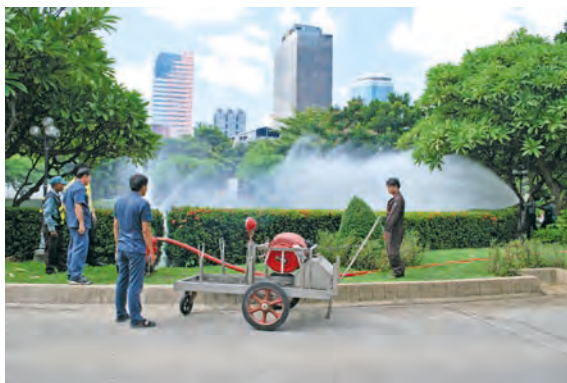
การทดสอบระบบเครื่องสูบน้ำดับเพลิงเป็นประจำทุกเดือน
