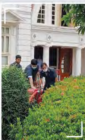
การทดสอบระบบเครื่องสูบน้ำดับเพลิงเป็นประจำทุกเดือน
