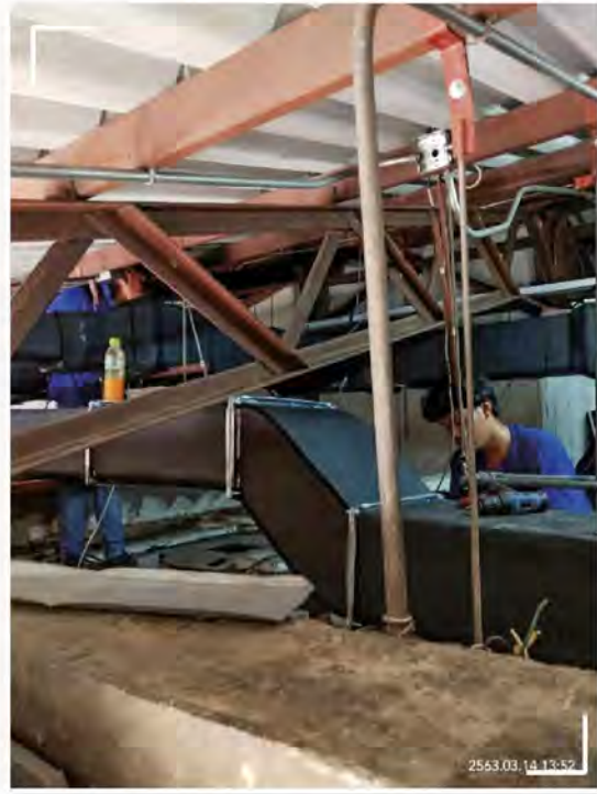
งานปรับปรุงท่อนลมและตู้มฉนวน
