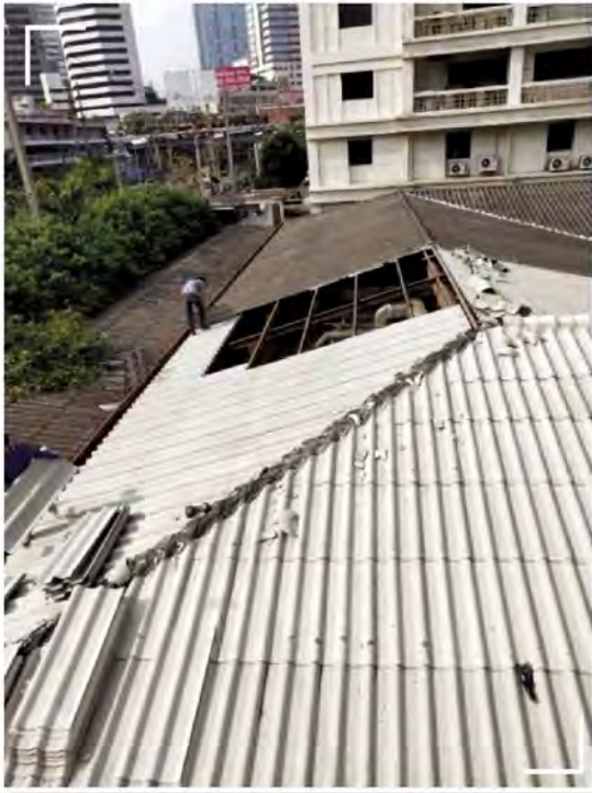
งานปรับปรุงหลังคาอาคารสัตว์ทดลอง
