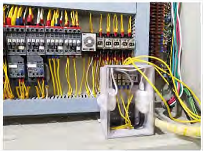
อุปกรณ์ IoT ที่ติดตั้งเพิ่มในตู้ควบคุม
