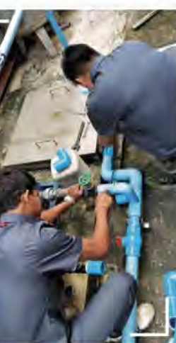
งานซ่อมท่อประปา
